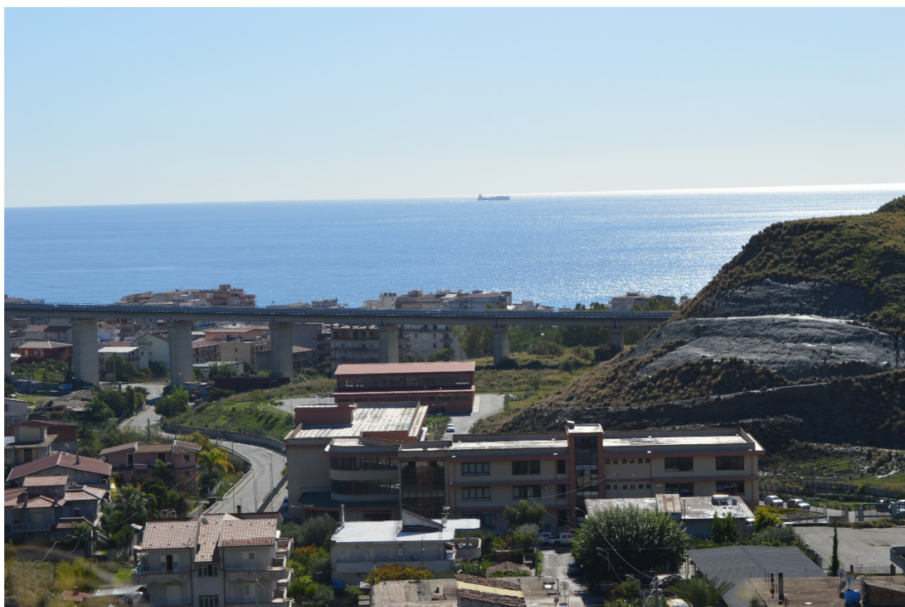
La strada statale 106 Jonica su viadotto a Bova Marina (8 11 2019)
